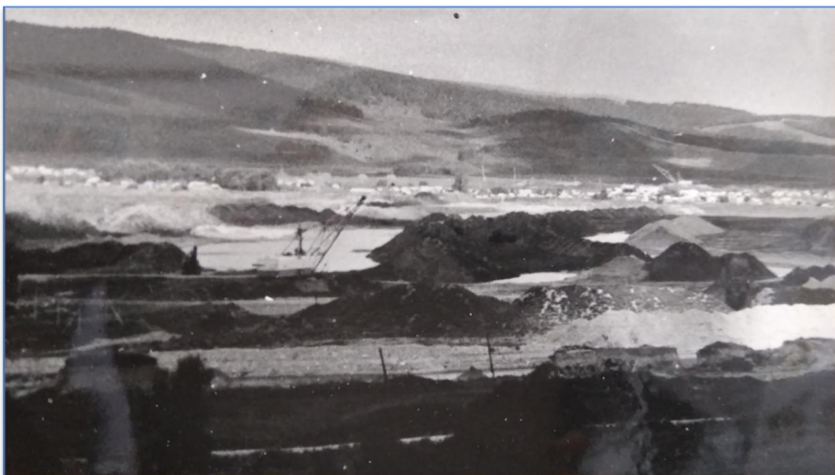
Панорама на строительство водохранилища со стороны р. Белой, 1986 год
