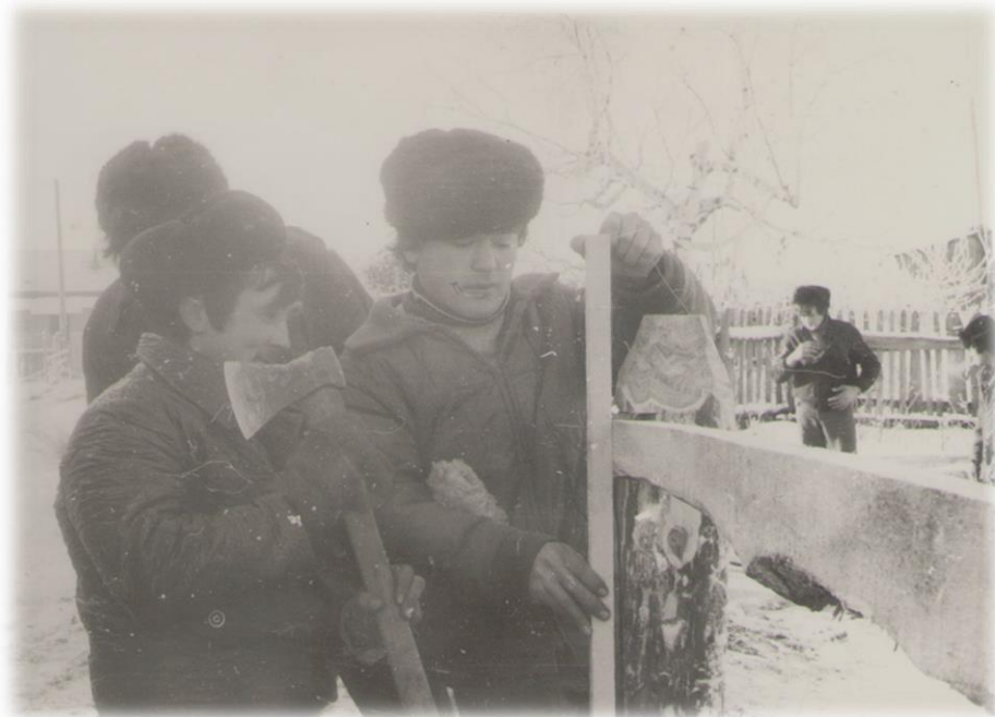
Комсомольский субботник, ремонт ограждения территории сельского клуба д. Иштуганово, осень 1982 год
