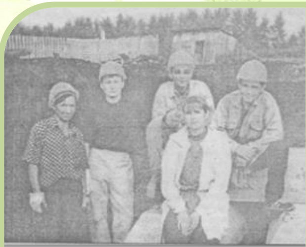
Строительство мечети Бригада строителей СУ - 4 АО "Мелеузстрой"
